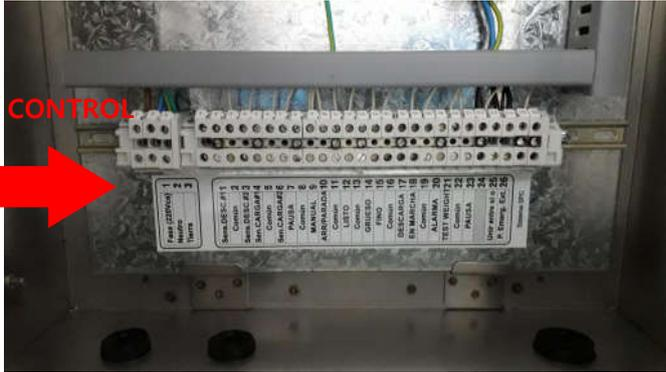
Destapamos las cajas y llevamos los cables de conexión pasándolos por los prensacables correspondiente, tanto en las cajas de conexiones como en el indicador y embornamos según indican las tablas de conexionado.
